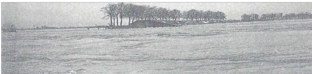
Abb. 9: Deichbruch bei Reitwein 1947.
