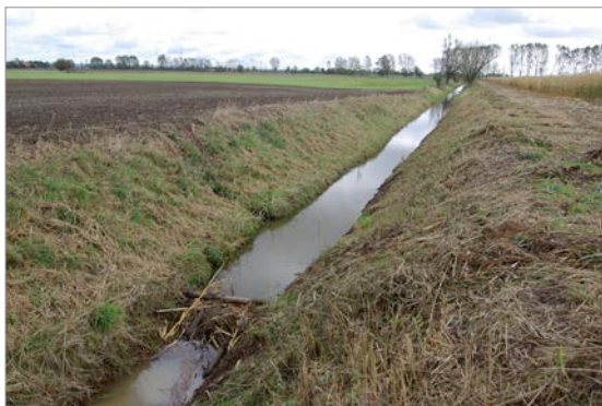
Abb. 34: Ein Biberdamm staut das Wasser im Entwässerungsgraben.
