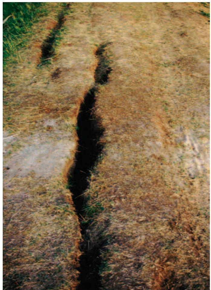
Die Erosion der Deichkrone am Krumpfen Ort durch überstömendes Oderwasser war der Auslöser der Katastrophe.
